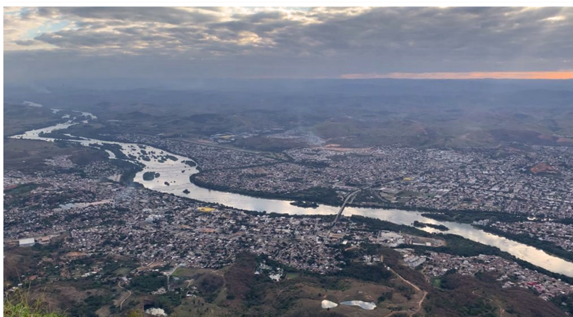
Figura 08. Vista da cidade de Governador Valadares cortada pelo rio Doce, no qual se observa que a cidade se espalha pela planície aluvial, terraços e morros. Também pode ser observado as ilhas fluviais do rio Doce, formadas pelos sedimentos que esse transporta, bem como o mar de morros ao fundo. Fonte: Registro fotográfico feito, a partir do pico da Ibituruna, por Haruf Salmen Espindola.
