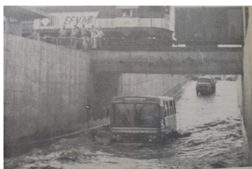
Enchente 1985 - viaduto Acervo: DRD
