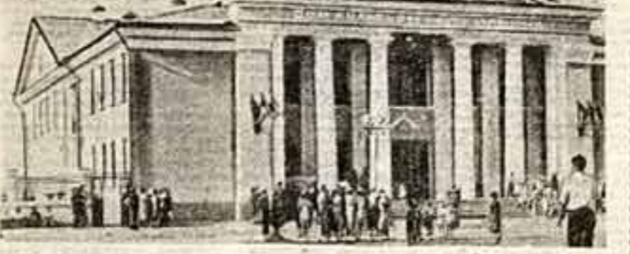
Челябинская область. Новый Дом культуры рабочих первого городского завода в поселке Потанино. Фото В. БОЙМЛЕВА (ТАСС).
