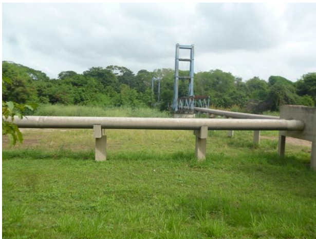
Foto 5.26 – ETE Ipanema – Adutora de Esgoto
