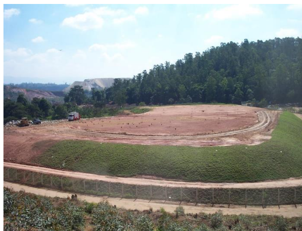
Foto 5.97 – Antigo aterro sanitário de Ipatinga
