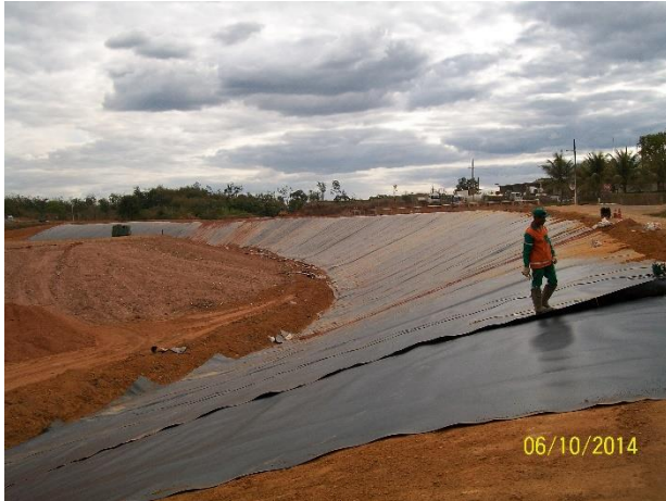
Foto 5.64 – Impermeabilização do solo com PEAD
