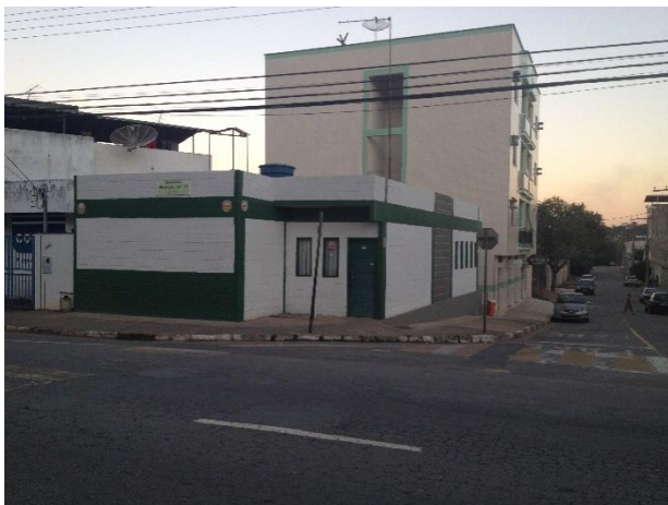
Foto 5.50 – Ponto de Apoio do bairro Panorama
