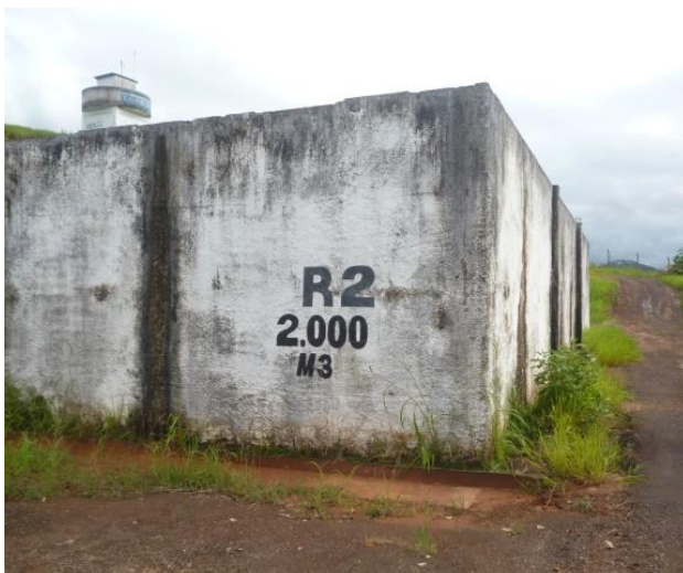
Foto 5.11 – Complexo de Reservação – R.2
