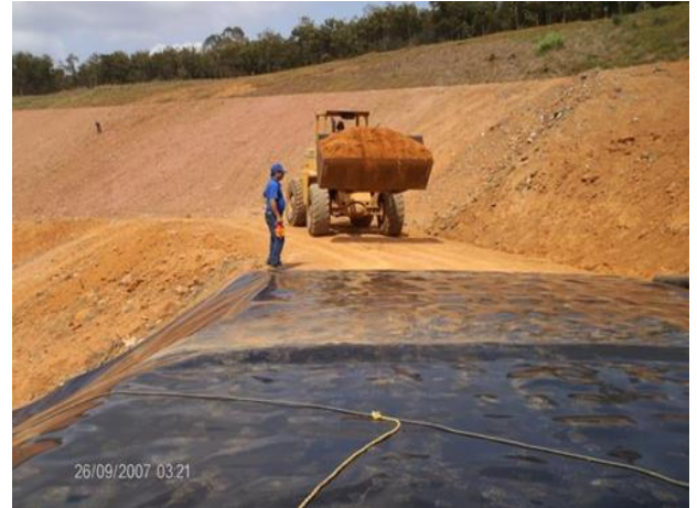
Foto 5.65 – Camada de proteção da geomembrana
