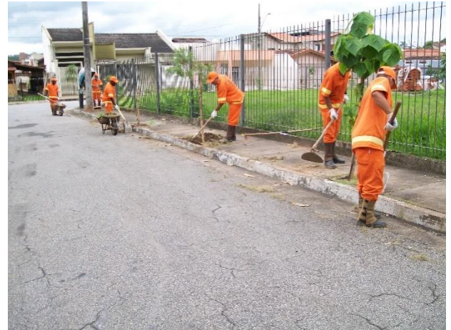
Foto 5.58 – Serviços de limpeza de sarjetas
