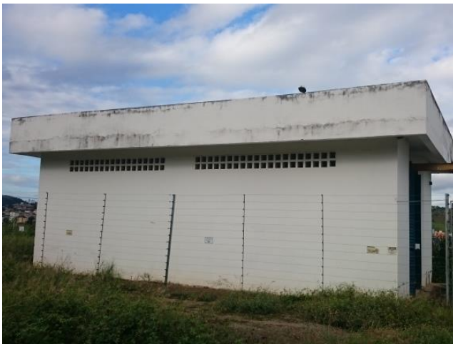
Foto 5.18 – EAAB RSE-03 – Casa de Bombas
