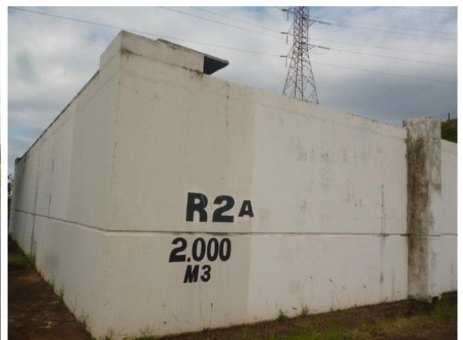
Foto 5.12 – Complexo de Reservação – R.2A
