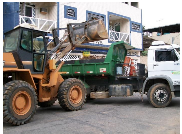
Foto 5.90 – Remoção mecanizada de inertes
