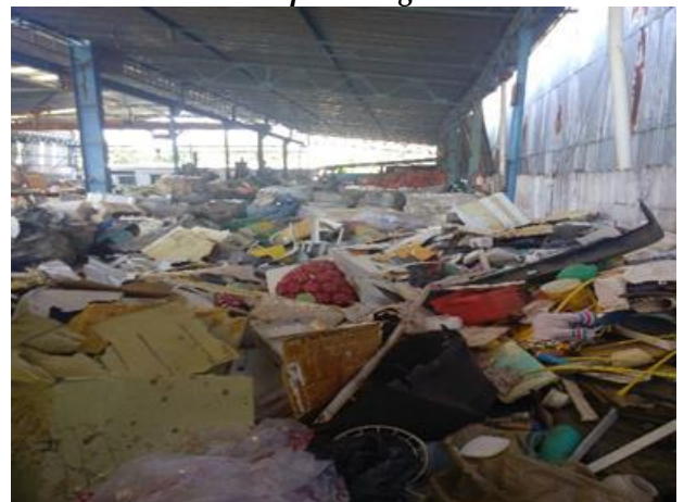
Foto 5.76 – Vista geral do galpão
