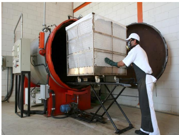
Foto 5.93 – Autoclave para tratamento dos RSS
