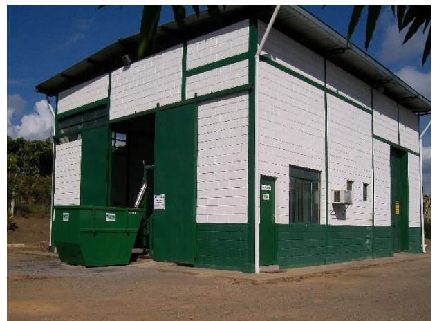
Foto 5.94 – Unidade de tratamento dos RSS
