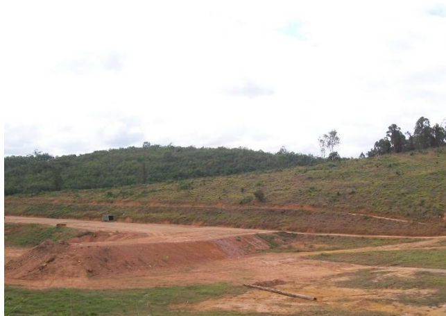
Foto 5.91 – Aterro de inertes na CRVA
