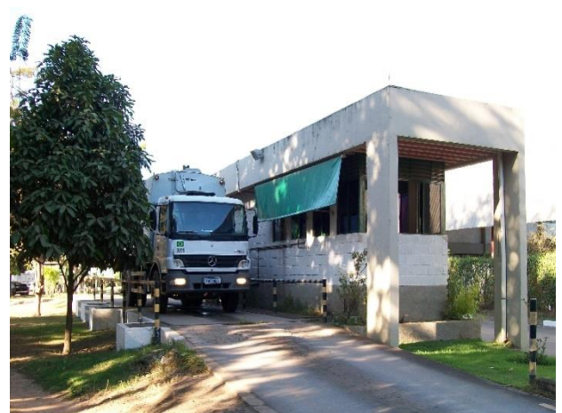
Foto 5.63 – Balança do aterro sanitário
