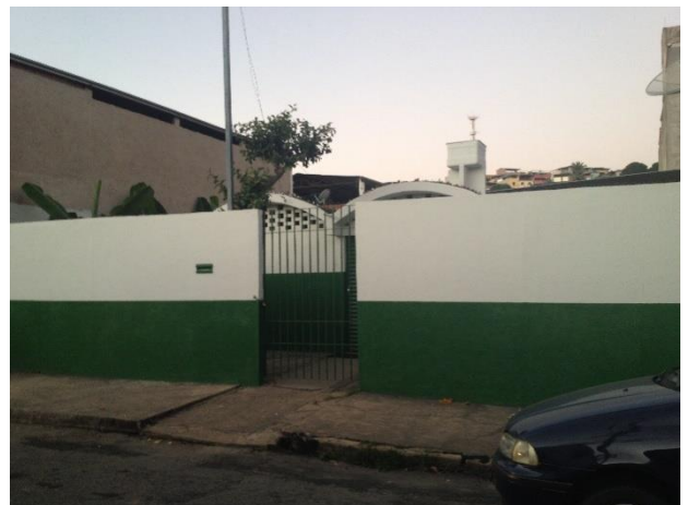
Foto 5.51 – Ponto de Apoio do bairro Canaã
