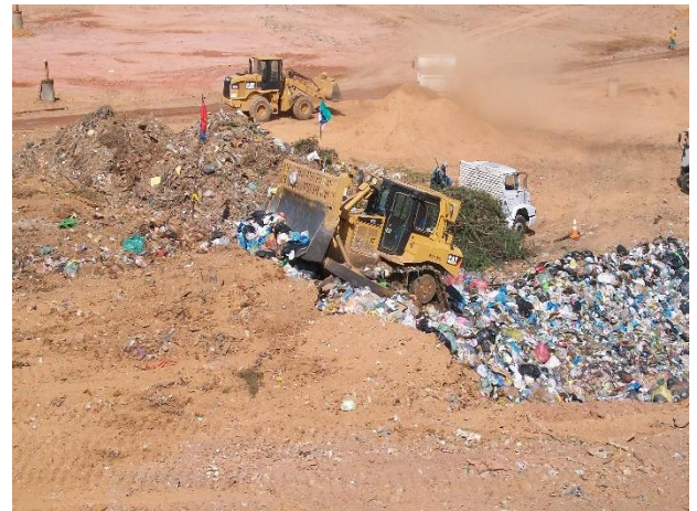
Foto 5.67 – Compactação dos resíduos
