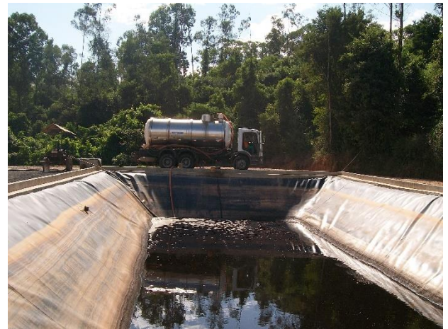
Foto 5.69 – Tanque de armazenamento de lixiviados
