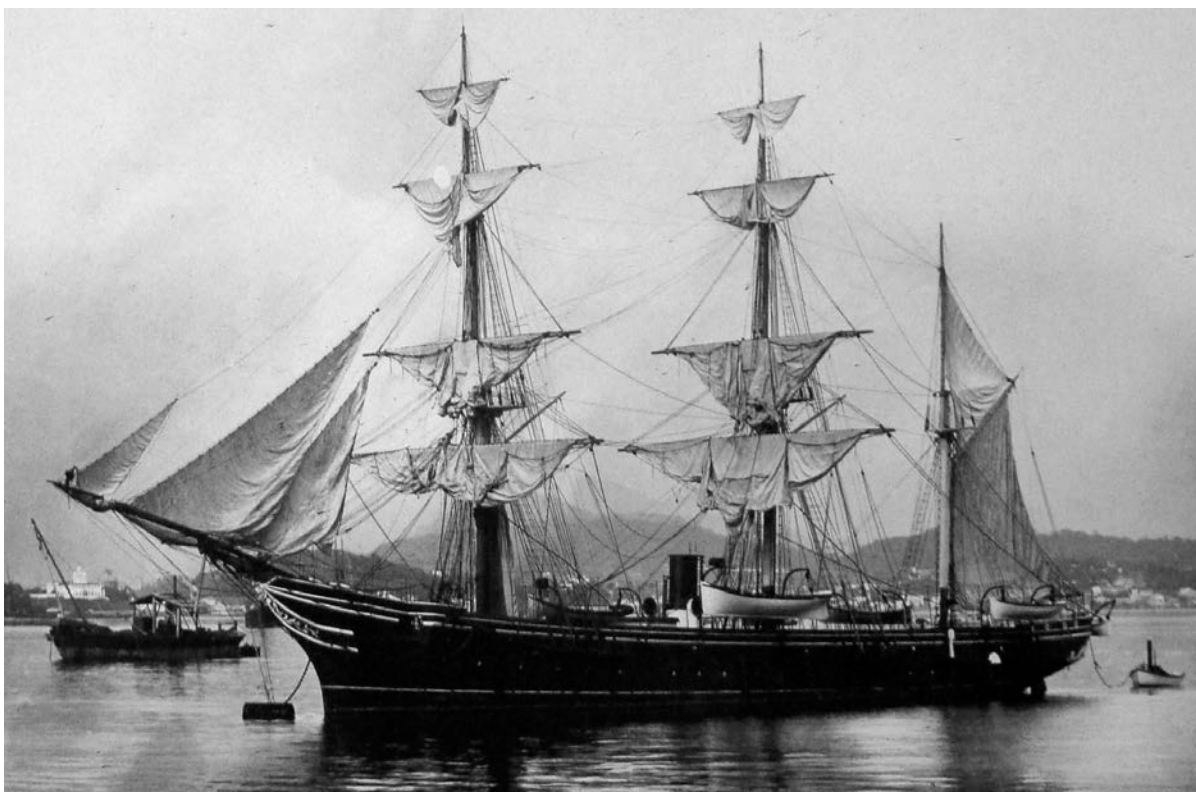
Imagem 38 – corveta / cruzador Imperial Marinheiro, navio construído no estaleiro Ponta da Areia a partir de projeto de João Cândido Brasil, que teve a quilha batida em agosto de 1882, foi lançado ao mar em junho de 1883 e incorporado em novembro de 1884. Com 726 toneladas de deslocamento, 65,1 metros de comprimento e 8,4m de boca, era um dos quatro representantes da série de menor porte das corvetas de emprego oceânico, estas construídas no Arsenal de Marinha da Corte após a Guerra do Paraguai – DPHDM (foto Marc Ferrez)
