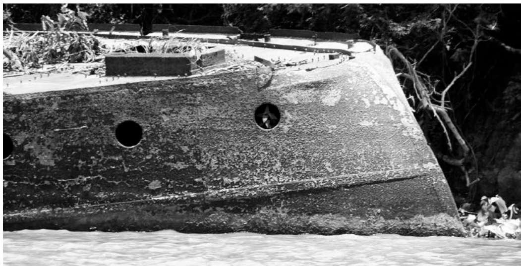
Imagem 3 – Na última vigia de bombordo do navio vê-se uma planta, enraizada onde no passado os oficiais do Paraguassu passaram suas horas livres, posicionada para receber um pouco mais de sol. Em meio às marcas de corrosão, são visíveis os contornos de alguns elementos estruturais da área da superestrutura da popa, assim como algumas linhas de rebites que acompanham esses elementos. – Foto do autor
