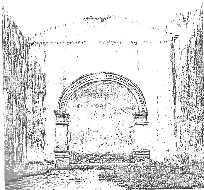
Interior. Arco e abside semi-circular.
