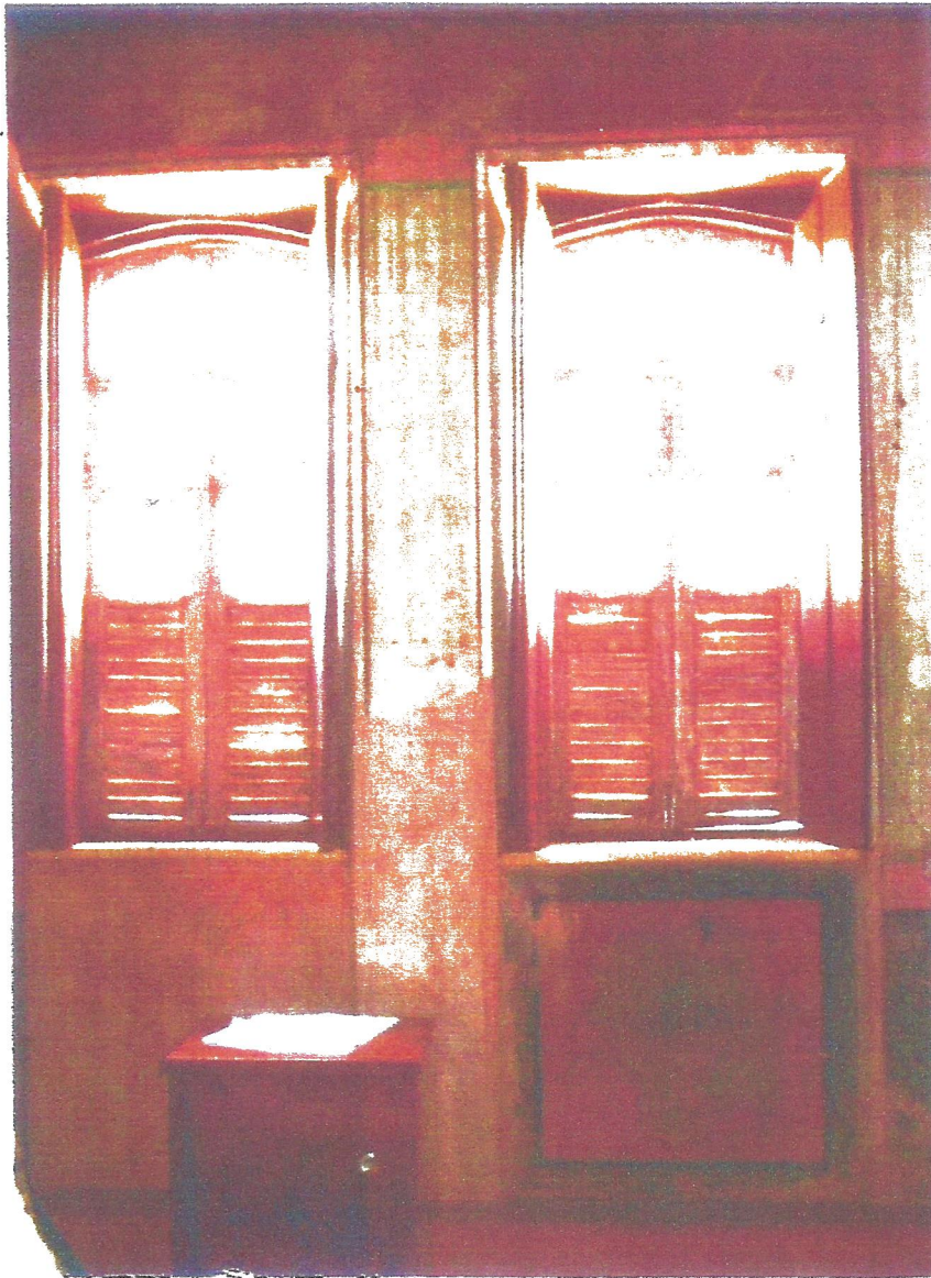
Janelas do cômodo anterior. Notar lacunas devidas à ação da umidade e reconstrução do reboco.
