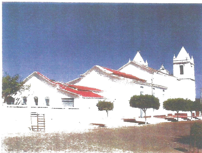
Fachadas posterior e lateral. Observar vão cujas proporções, localização e esquadria descaracterizam a fachada posterior
