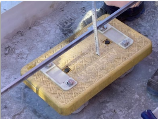
Probeweise auf Fester Fahrbahn eingebaute Balise
