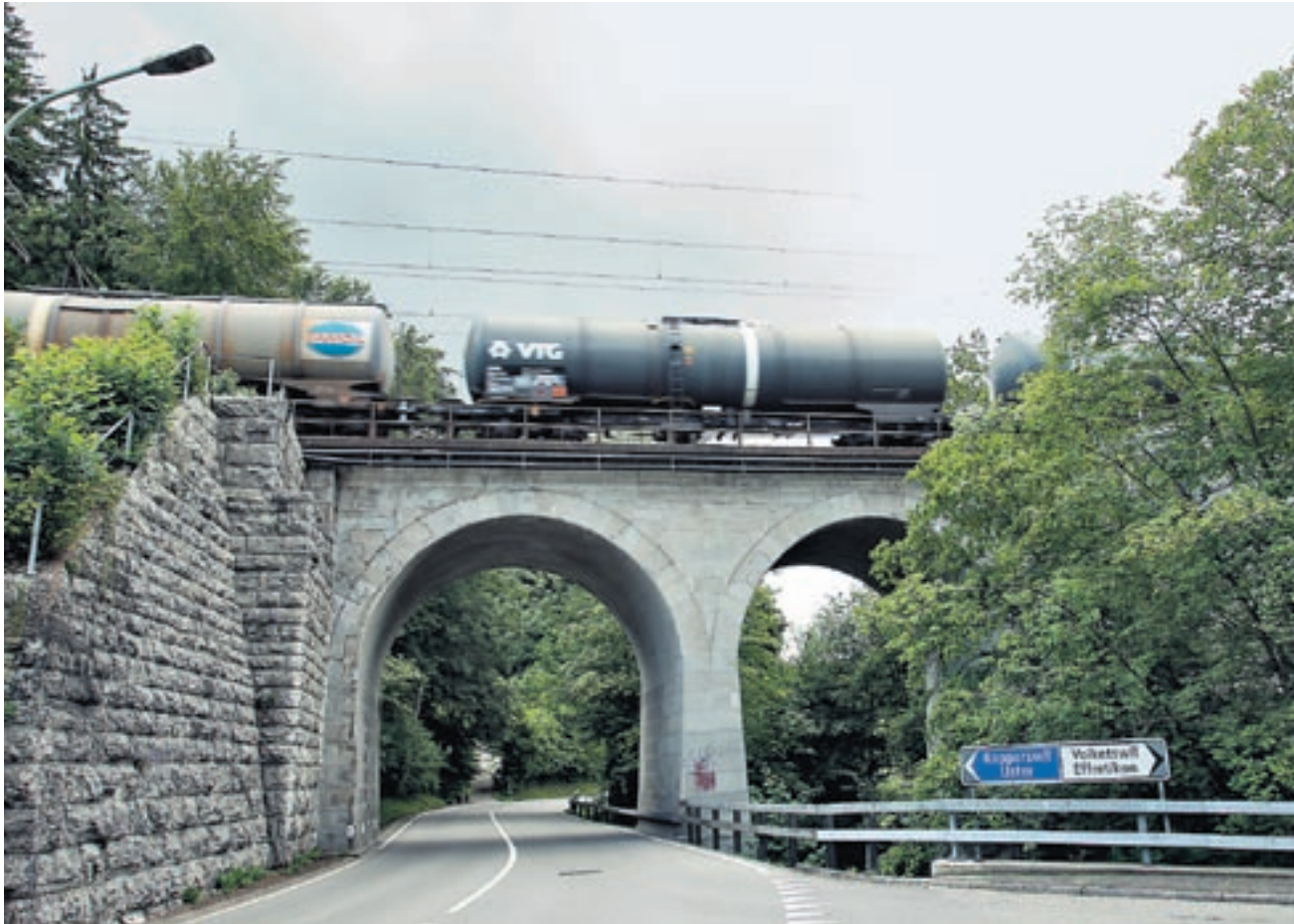
An der Kemptbrücke zwischen Kemptthal und Effretikon sind heute noch Spuren des «dritten Gleises» zu erkennen (Reste eines Stützpfilers links im Bild). Ursprünglich war die Brücke breiter; sie wurde aber nach dem Konkurs rückgebaut. Bild: Donato Caspari
