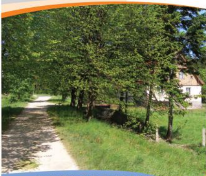
Droga Złoty Stok - Łądek-Zdrój (przed modernizacją)
