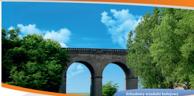
Arkadowy wiadukt kolejowy
