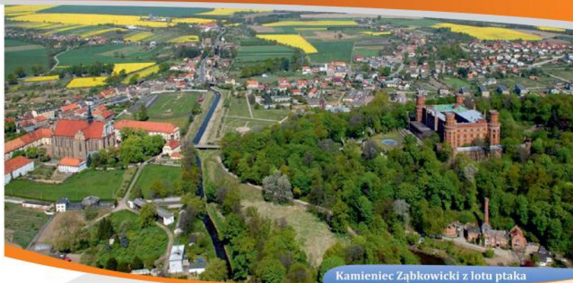
Kamieniec Ząbkowicki z lotu ptaka
