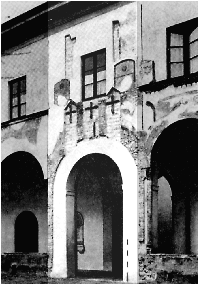
Tracce della torre longobarda nel Monastero di Santa Maria Theodote, detto "della Pusterla", a Pavia.
