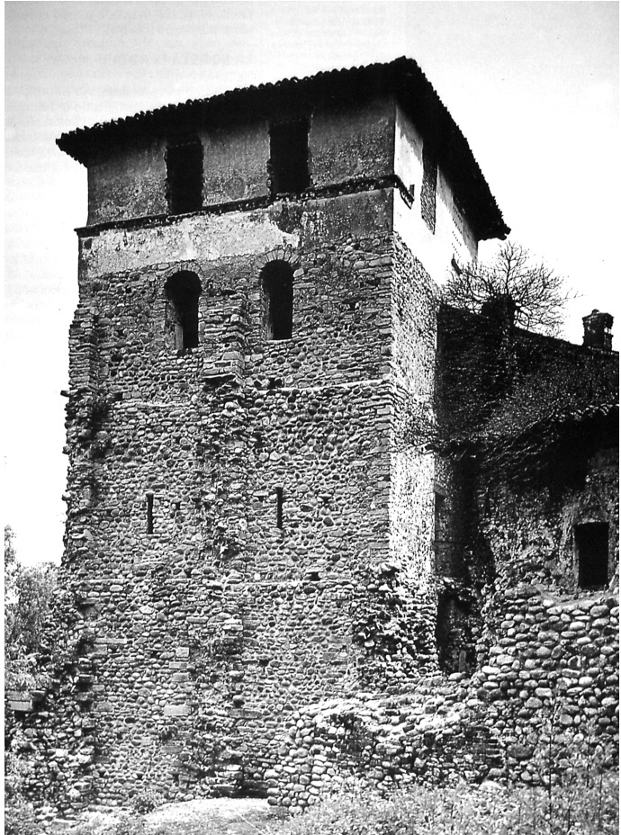
La torre del Monastero di Torba, presso Castelseprio.
