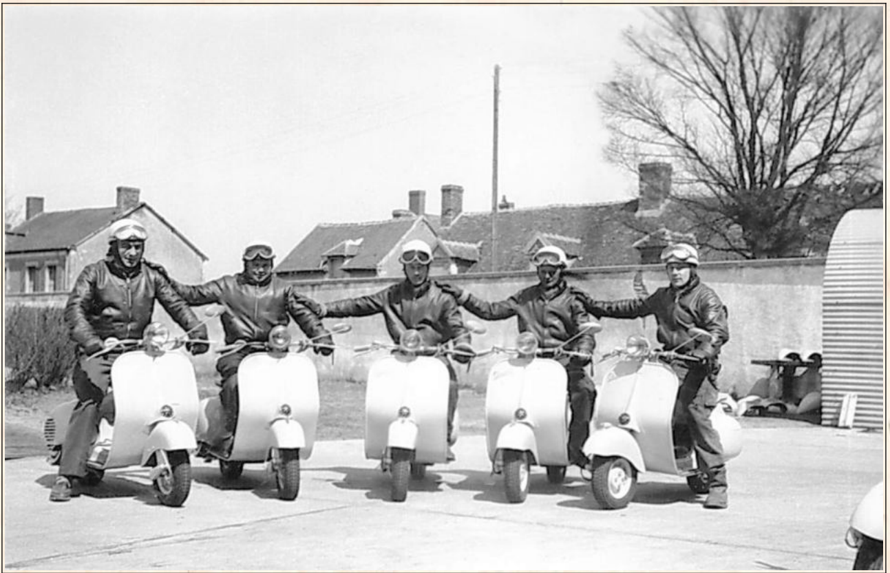
Profession : Essayeur ! L'anneau d'essai des scooters, plus grand qu'un stade de football. A l'époque nous étions 15 sous les ordres de Jean Véron afin de procéder aux réglages des freins, des suspensions, du ralenti et du passage des vitesses, avant une ultime finition sur la chaîne.
