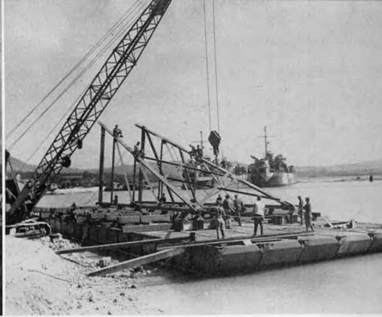
75 Ton crane erection
