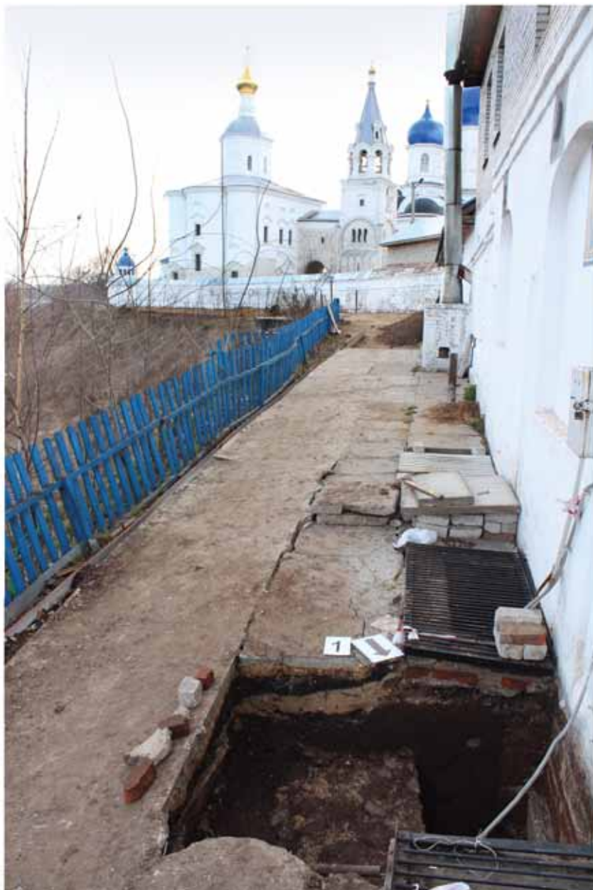
Рис. 3. Вид стены в шурфе 1 и Боголюбовского комплекса
