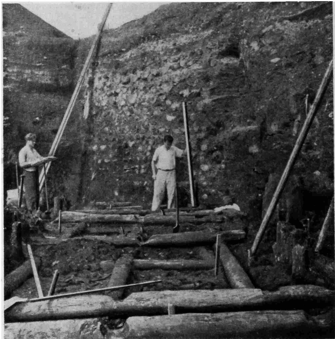
Рис. 7. Мостовая 23-го строительного яруса.
