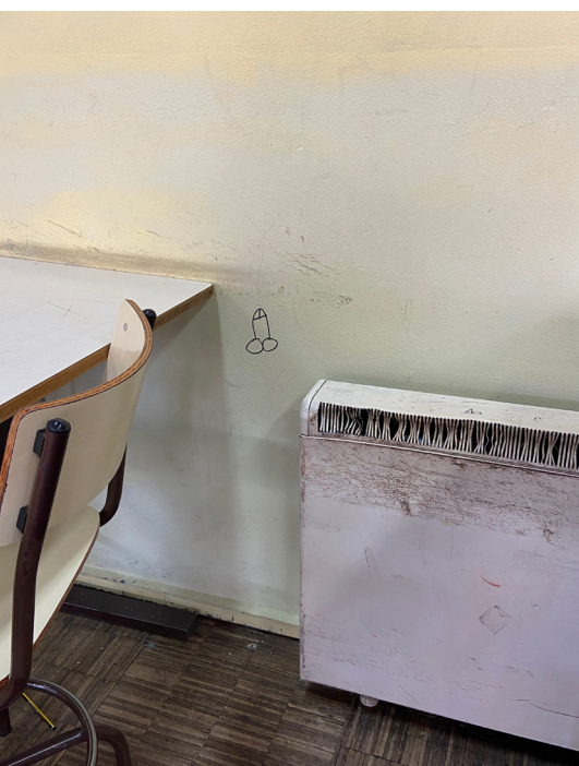
IMG 5. Parede da sala de aula de EV.
