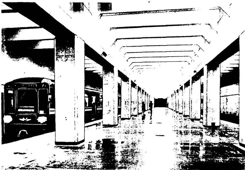
Рис. 18. Станция Студенческая (Новосибирск)
