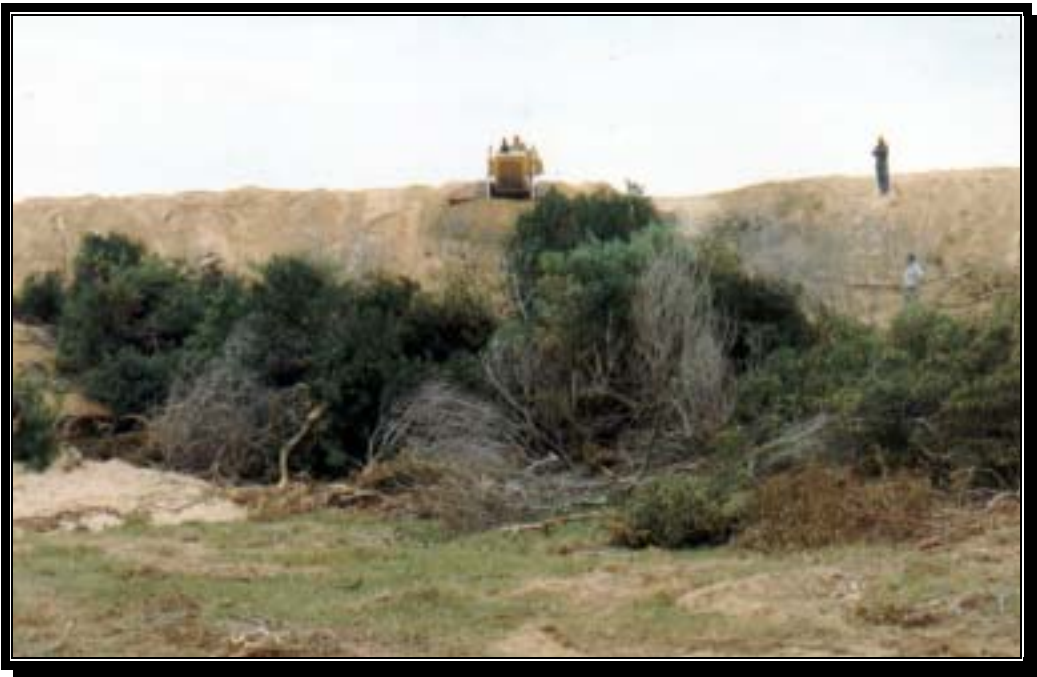
Figura N° 7. Apeo de árboles y vegetación asociada con topadora D6; se observa el empastamiento en la zona aledaña a la cortina.
