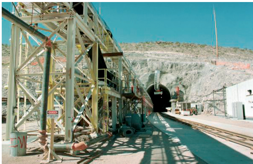
► Figura 6. Trabajos en el depósito de almacenamiento de residuos de Yucca Mountain (Estados Unidos).
