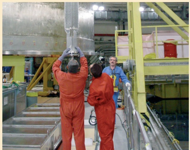
Trabajos en el interior de la central nuclear de Cofrentes.
