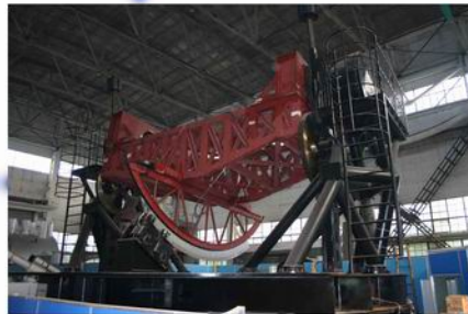
在车间装配中的 M_A 机架和跟踪装置 Mounting and tracking mechanism of M_A in workshop
