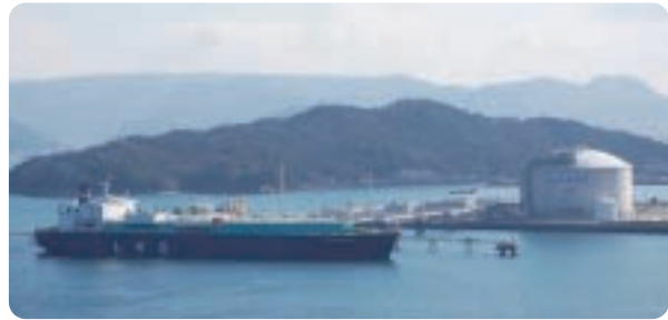
坂出LNG基地
