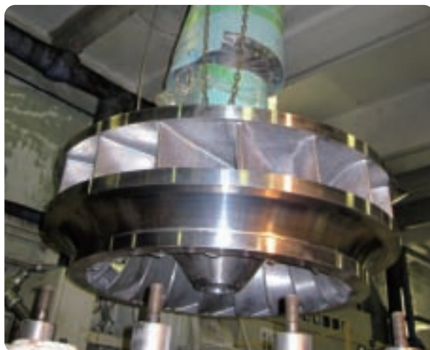
出合発電所(水車の取替え)
