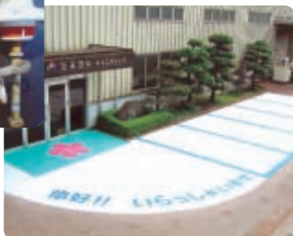
透水性カラー舗装
