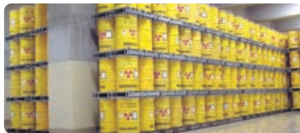
伊方発電所の固体廃棄物貯蔵庫
