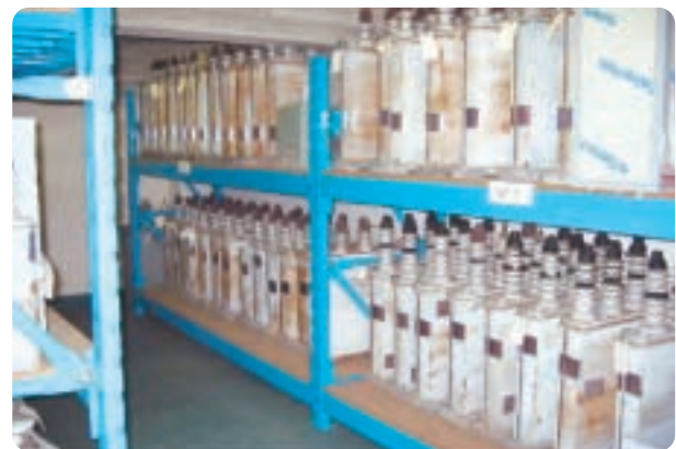
PCB使用機器の保管状況
