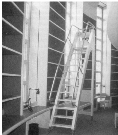
Staatliche Hochschule für Musik und Darstellende Kunst, Stuttgart (Neubau 1996; Architekt: James Stirling) Die in Schienen gelagerte Bockleiter dient zum Bedienen der raumhohen (6,5 m) Regale. Beim Fahren müssen die Leseplätze geräumt werden.
