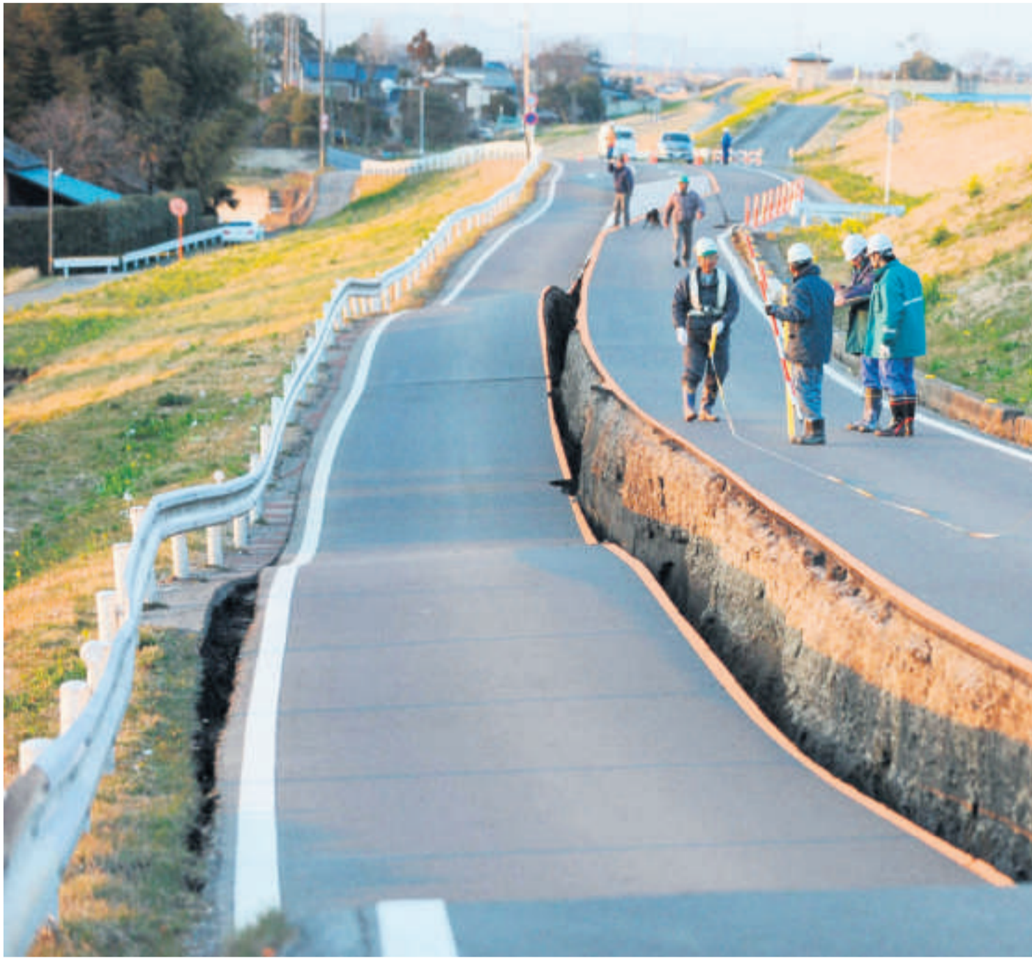
Die Folgen des Bebens vom 11. März am Japan-Graben: Zerstörte Strasse in der Präfektur Saitama
