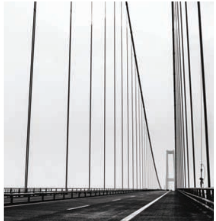
Østbroen over Storebælt.
