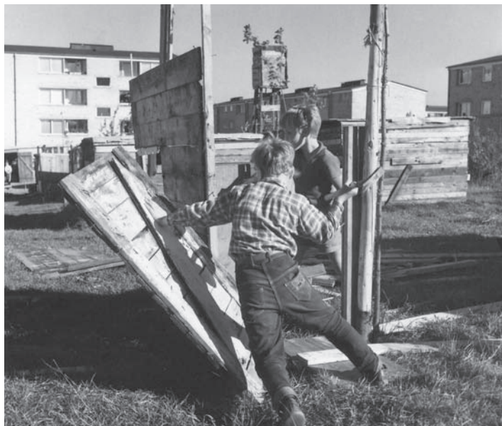
Tingbjerg Byggelegeplads 1961. Foto: Københavns Bymuseum.
