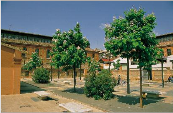
Espacio interior del Matadero, ya convertiro en Centro Cívico
