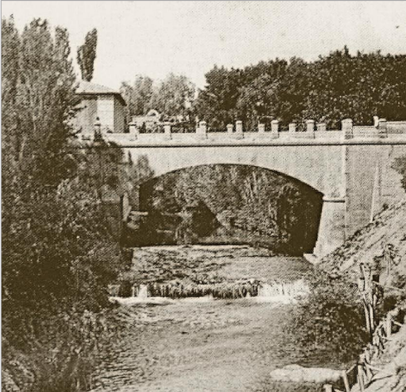
Puente sobre el río Huerva
