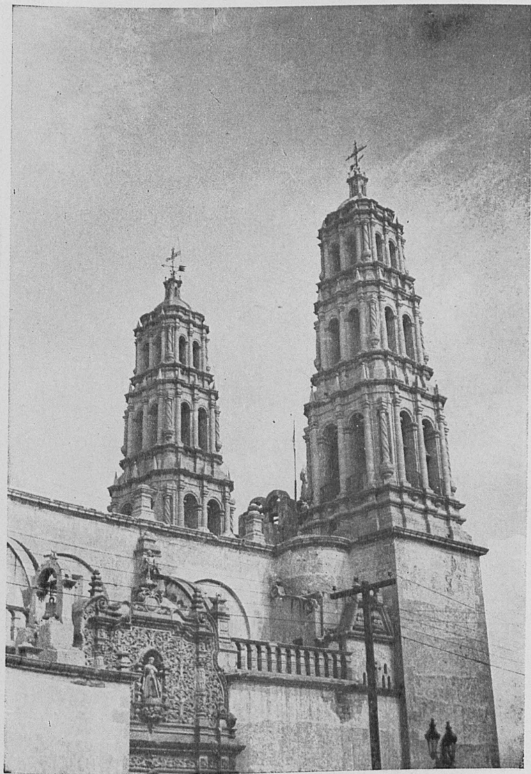
17. Fachada lateral y torres.
