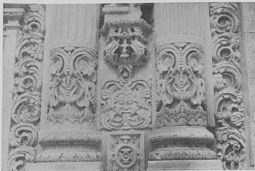
15. Fachada lateral. Detalle.
