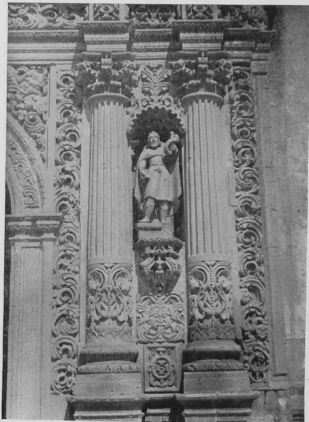
14. Fachada lateral. Columnas.
