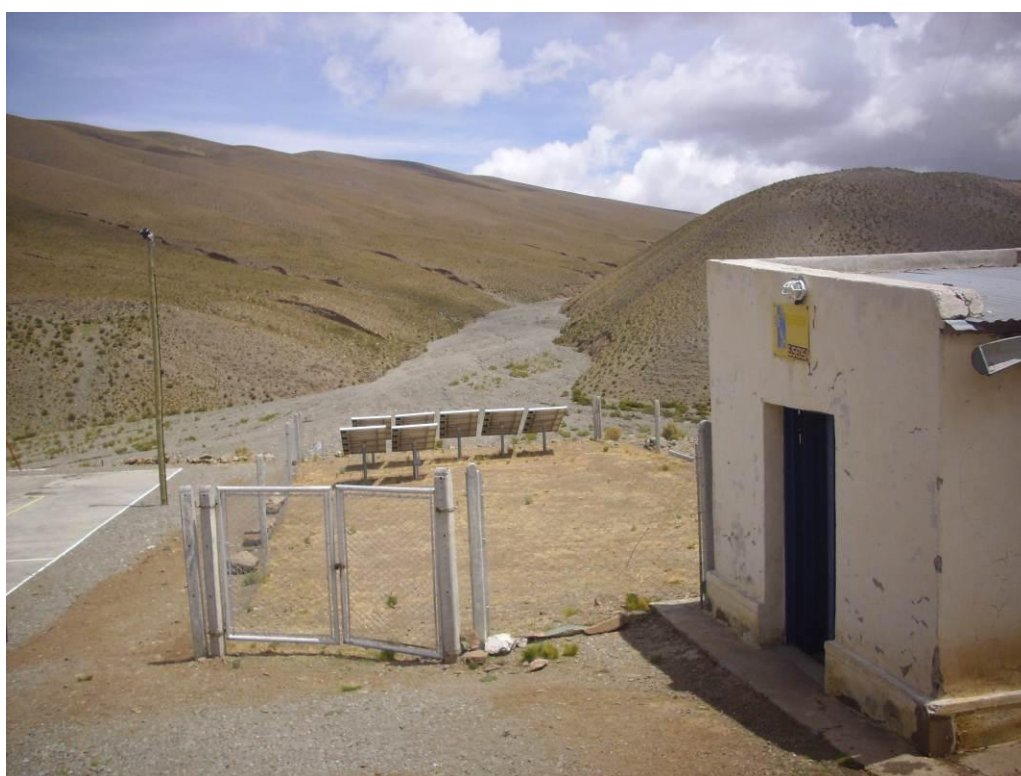
Fig. 17. Trabajadores en Puna y Usina
