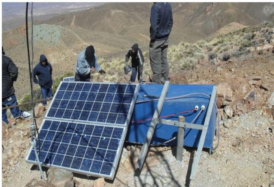
Fig. 11 Instalación de Repetidoras
