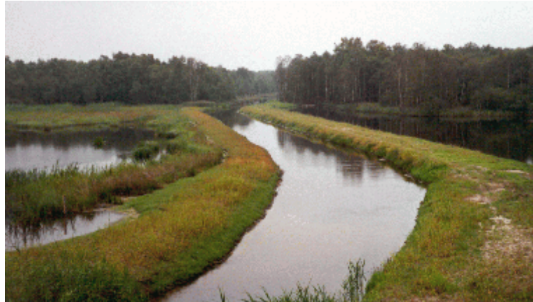
De Tungelroyse Beek net na de duiker onder de Zuid-Willemsvaart in juli 2000. De beek en de oevers zijn hier reeds gesaneerd.
