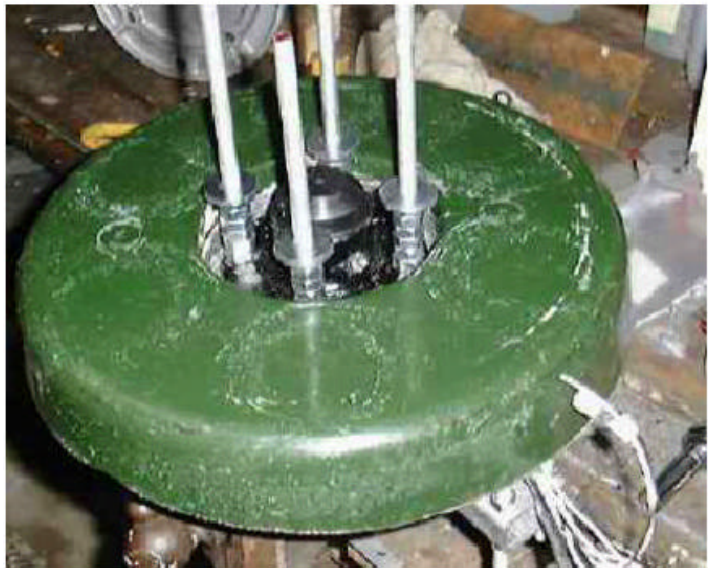
Montering af stator
