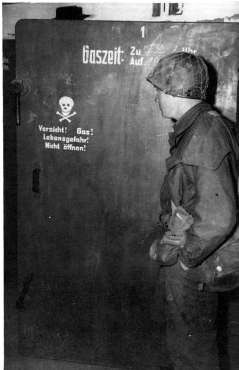
Abb. 21 : Tür der Desinfektionskammer von Dachau
