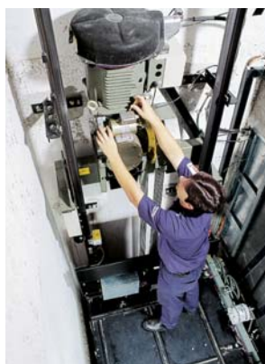
Conjunto de tração no interior da caixa ▶
