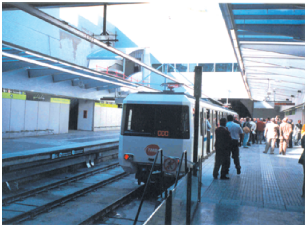
Estació a cel obert de Torre Baró-Vallbona de la nova línia 11.
