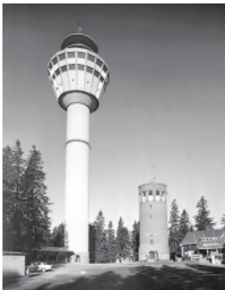
Puijon vanha ja uusi torni kesällä 1963.
