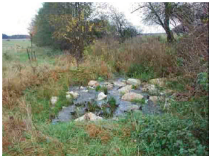
Abb 3: Eine Renaturierungsmaßnahme durch den NABU Wehrheim: Eine „Geröllrampe“ zur Verminderung der Fließgeschwindigkeit
