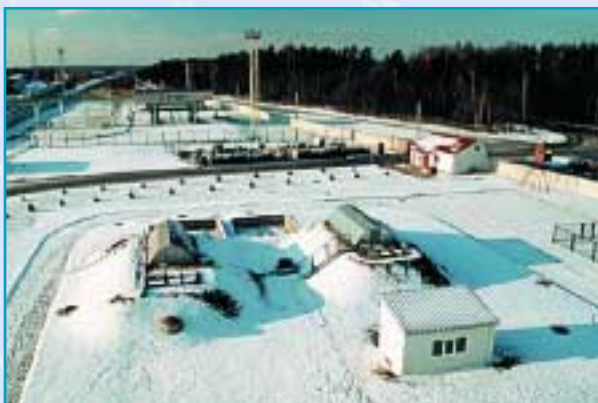
. Биологические очистные сооружения "Биодиск", КНТ у пос. Ижевское
