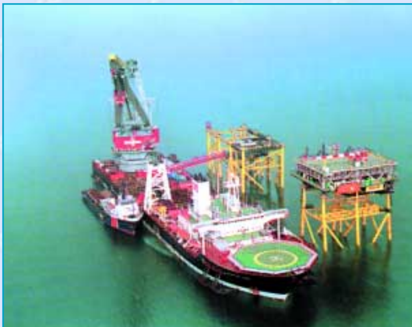
Краново-монтажное судно "Станислав Юдин" на строительстве морской стационарной платформы
