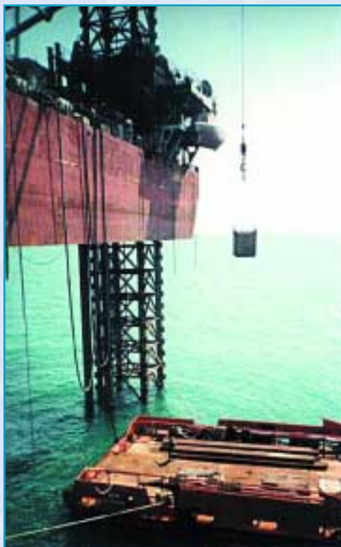
Выгрузка мусора с платформы в герметичном контейнере
