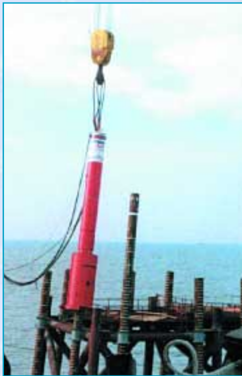
Экспериментальная забивка свай
