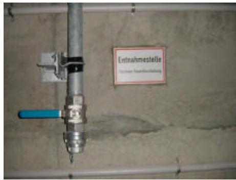
Abbildung 15: Schlauchanschluss-einrichtung
