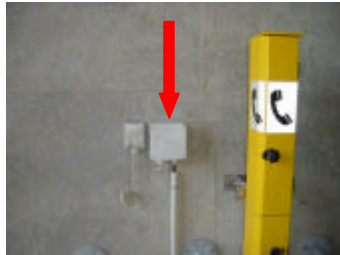
Abbildung 20: Anschlussdose für Fernsprecher neben Notrufsäule
