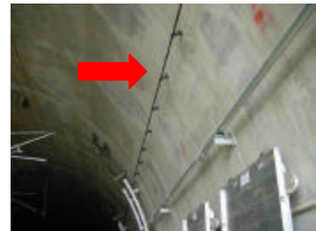
Abbildung 19: BOS-Strahlerkabel
