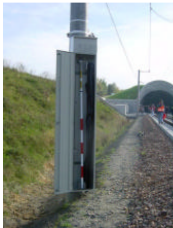
Abbildung 13: Erdungsvorrichtungen am Tunnelportal
