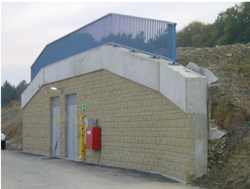
Abbildung 7: Notausstieg am Tunnel Idstein
