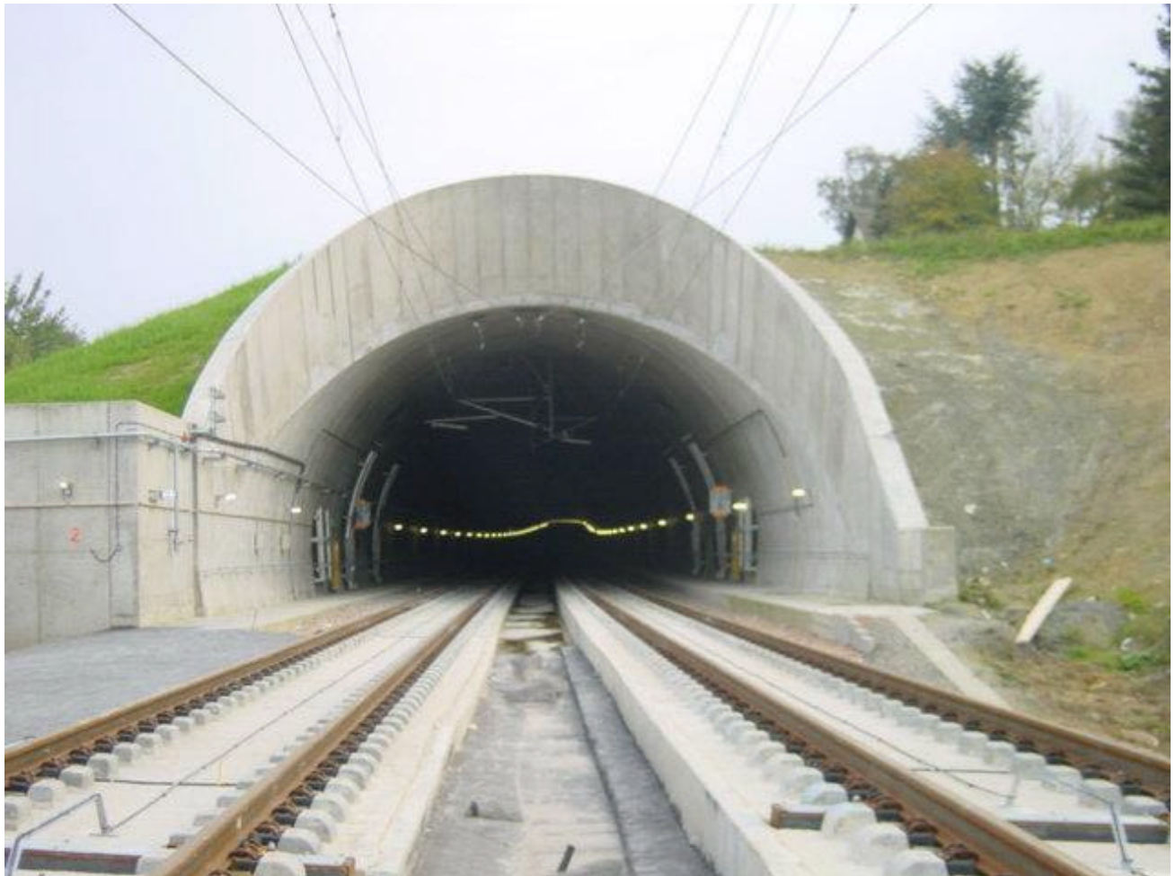
Abbildung 5: Blick in den Idsteiner Tunnel der NBS Köln-Rhein/Main
