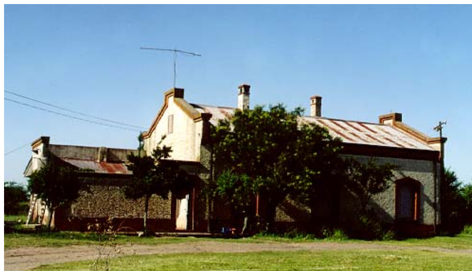
Estación ferroviaria de Sansinena.
