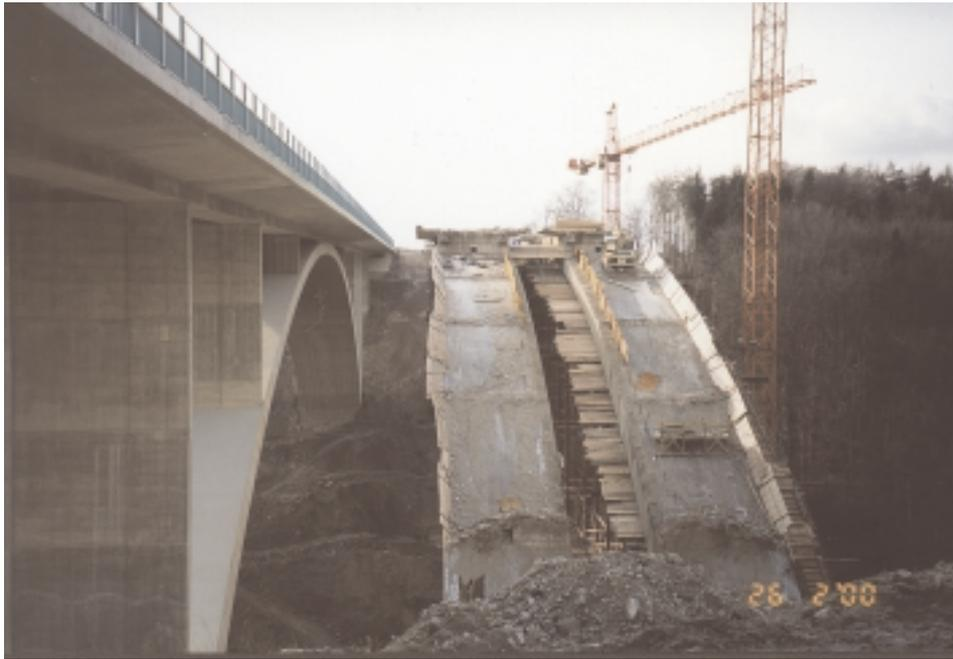
**Bild 1.33:** Teufelstalbrücke - Abbruch der aus den Jahren 1936 - 1938 stammenden Bogenbrücke
