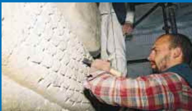
Une fois les pierres installées, il s'agit ensuite de sculpter les pétales des rosaces. Pour une meilleure uniformité du rendu, c'est un seul et même tailleur de pierre qui les réalise.
