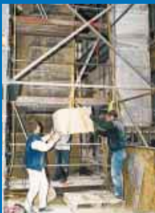
Les nouvelles pierres sont retaillées sur place avant leur mise en place. Parmi les pierres d'origine, une partie est réutilisée en complément pour combler et fixer les parements les moins visibles.
