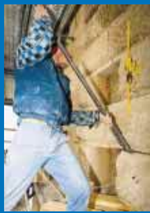
Les blocs d'origine pesant 400 kg sont extraits pour permettre leur remplacement par des pierres de la carrière de Pignan.
