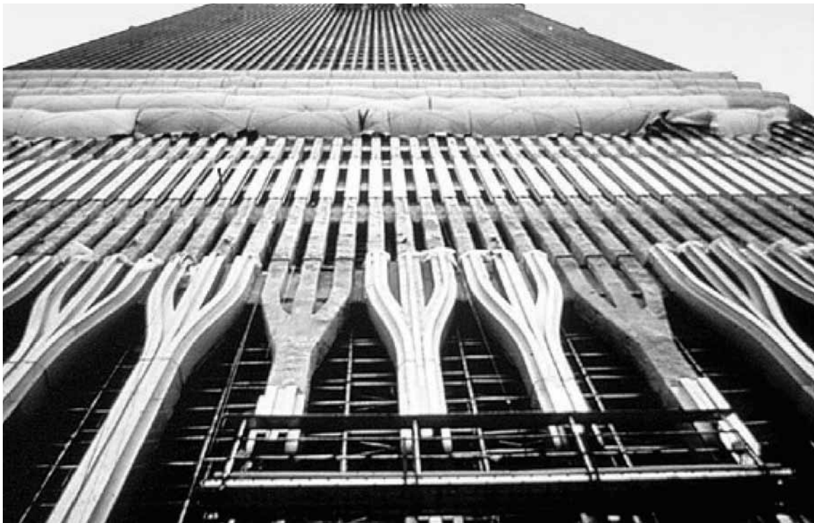
Bild 6: Sockelbereich der Rahmenröhre [1]
