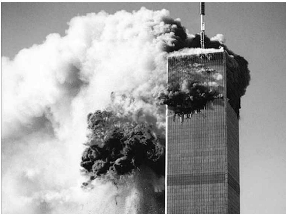
Bild 23: Feuerbälle nach dem Einschlag in den Südturm [1]
