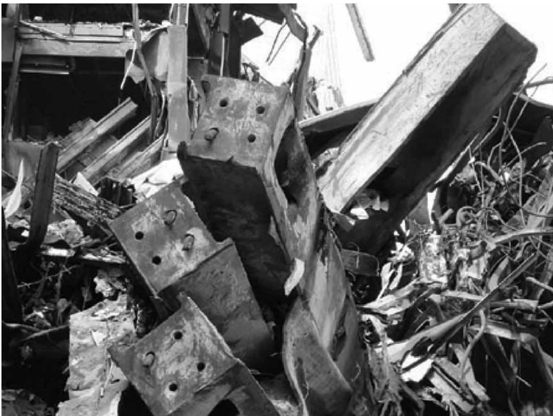
Bild 26: Kopfplattenstöße der Außenstützen [1]
