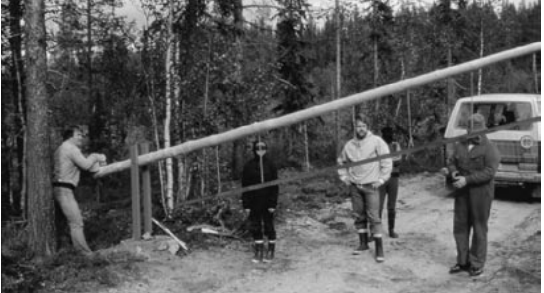
Puomia rakentamassa Heikki Virkkunen, Jyrki Vuorenmaa, Erkki Vuorenmaa ja Pekka Sarkkinen. (Kuva: Kalevi Rajala 23.7.82)
