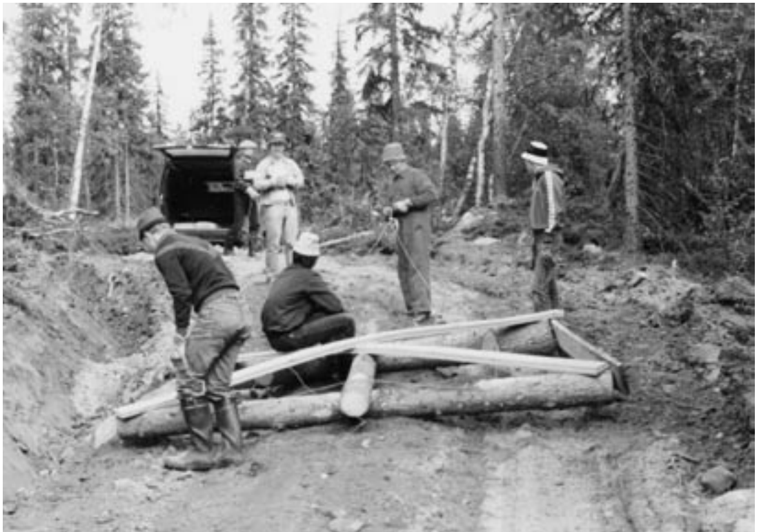
Tilustien kunnostaminen oli joka kesäinen työtehtävä. Sitä varten rakennettiin oma "tiehöylä" jota vedettiin pakettiauton perässä. Kuvassa Virkkunen, Sarkkinen ja leiriläisiä.
