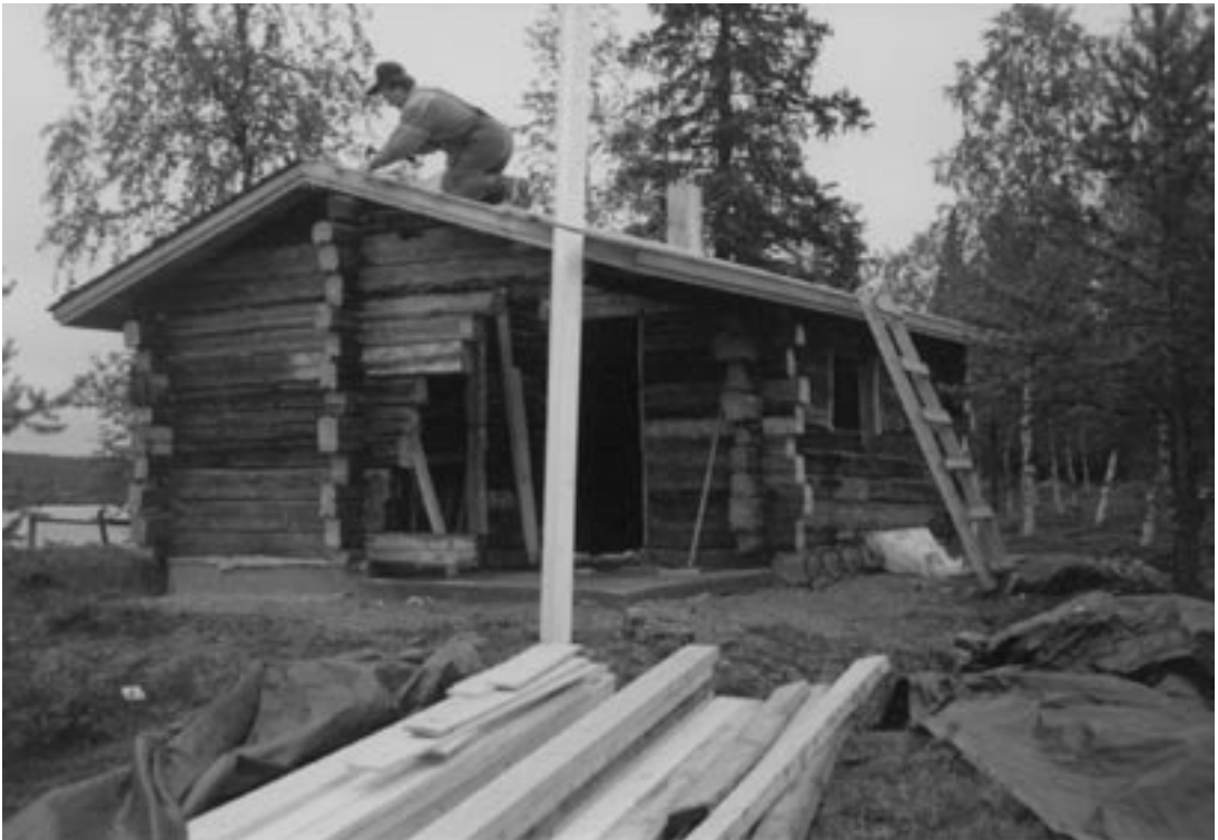
Reino Kunnari savusaunan kattoa rakentamassa.
