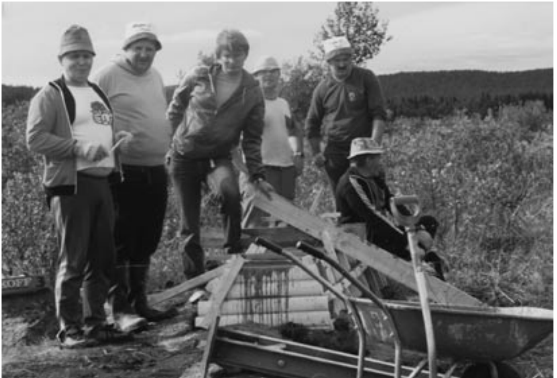
Lipputangon jalustaa valamassa pohjoiskarjalainen "työbrigaadi". Pekka Sarkkinen, Kyösti Vuori, Seppo Sarkkinen, Martti Härkönen, Reijo Lehikoinen ja Unto Sarkkinen. Tämän jälkeen porukka muurasi pirtin pätyyn savupiipun.
