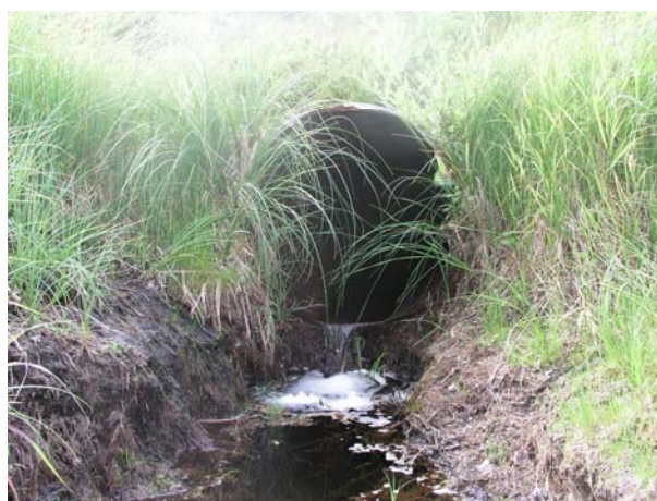
Bild 12: Åtgärdsobjekt D1 nedströms sett.
