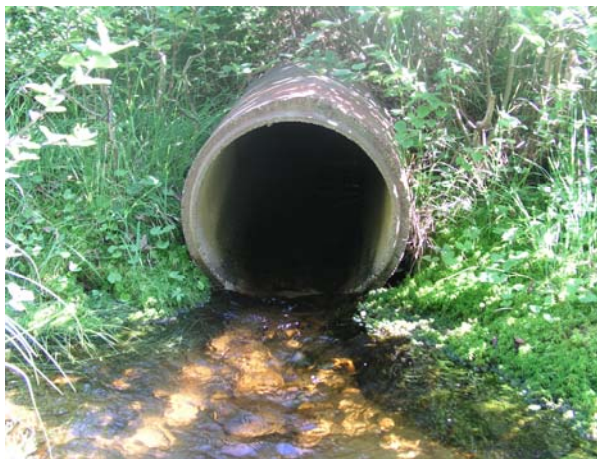
Bild 10: Åtgärdsobjekt C1 nedströms sett.
