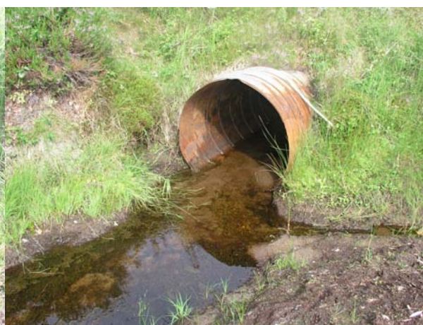
Bild 13: Åtgärdsobjekt D1 uppströms sett.
