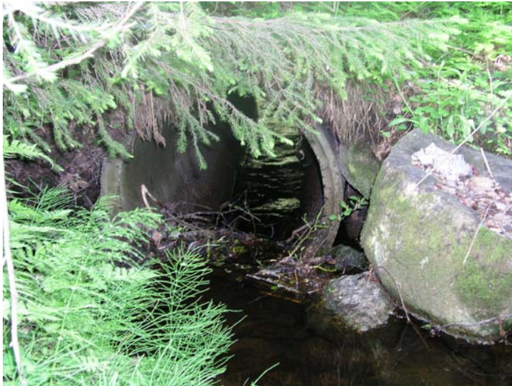
Bild 19: Åtgärdsobjekt E2 uppströms sett.
