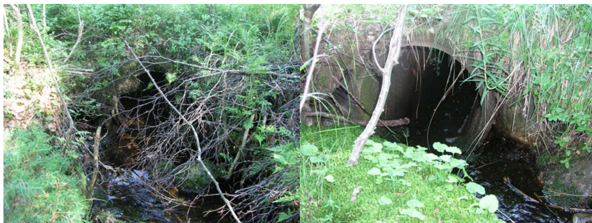
Bild 16: Åtgärdsobjekt D3 nedströms sett.
