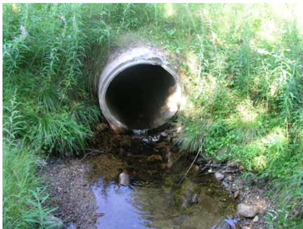
Bild 14: Åtgärdsobjekt D2 nedströms sett.
