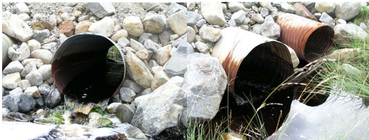
Bild 8: Åtgärdsobjekt B1 nedströms sett.
