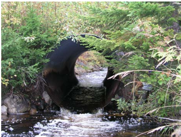
Bild 2: Åtgärdsobjekt A3 nedströms sett.
