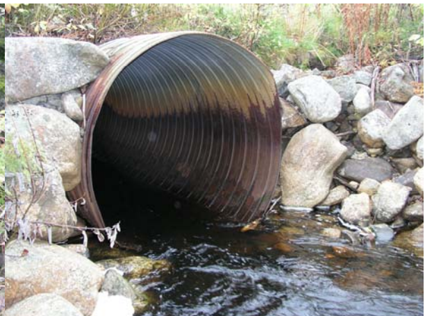
Bild 3: Åtgärdsobjekt A3 uppströms sett.
