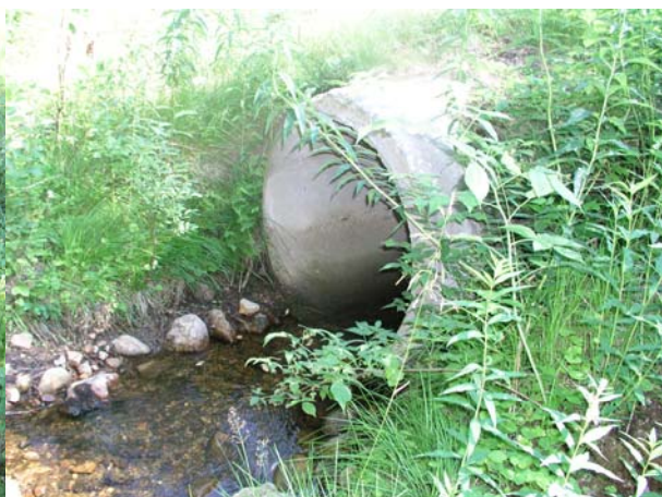
Bild 15: Åtgärdsobjekt D2 uppströms sett.
