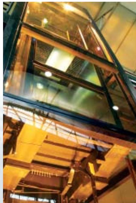
Smart<sup>MRL</sup> Panorâmico em caixa de estrutura metálica
