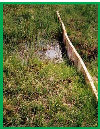
Lärchenspundwand in Nut-und-Feder-Konstruktion staut einen alten Entwässerungsgraben zur Regulierung des Moorwasserhaushalts auf.
