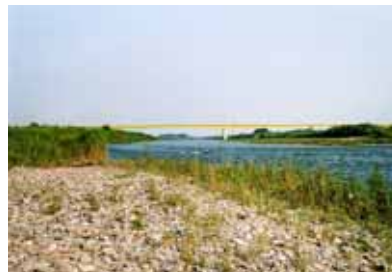
写真 - 2 荒川中流部（03,8,4 撮影）
