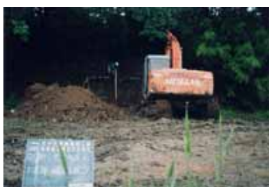
写真-28 カワセミ崖機械掘削
