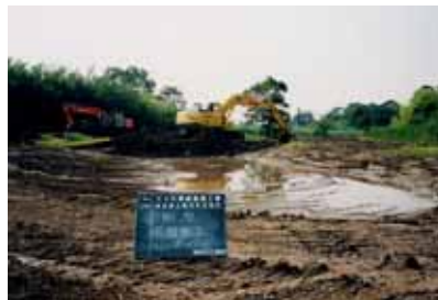
写真-32 沼造成掘削中
