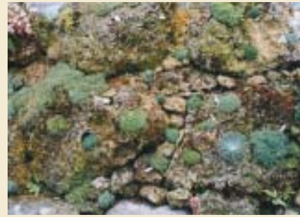
Tuffsteinwand mit Steinbrecharten Mur en tuf où poussent diverses variétés de saxifrages
