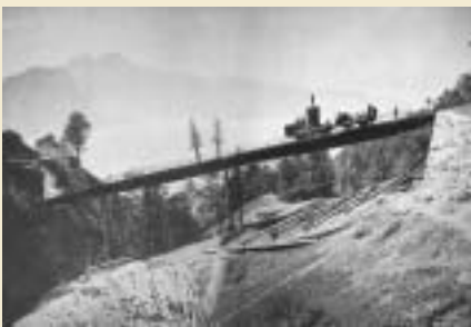
Schnurtobelbrücke der Rigibahn 1875 Chemin de fer du Rigi, pont de Schnurtobel 1875
