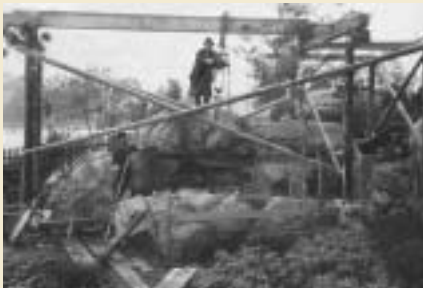
Schwere Felstrümmer werden mit Flaschenzug und Winde in die gewünschte Lage gebracht De gros rochers sont mis en place à l'aide d'un palan et d'un treuil.
