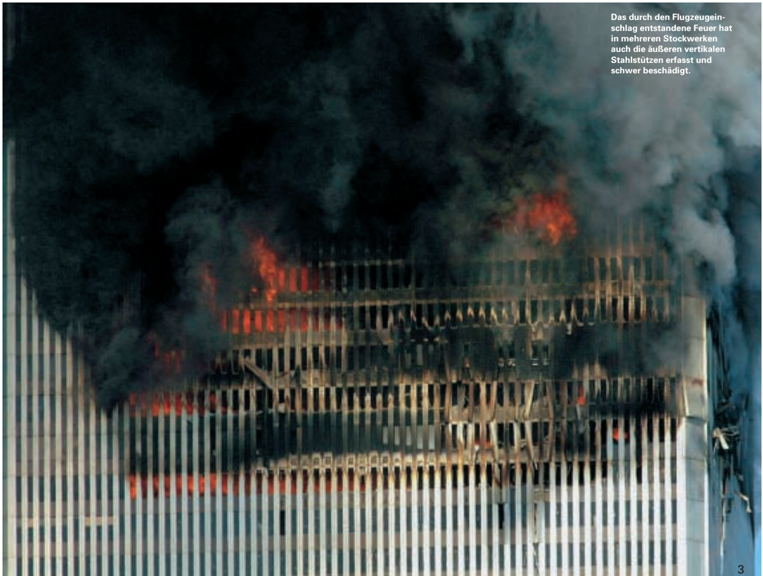
Fassadenfront des WTC.
