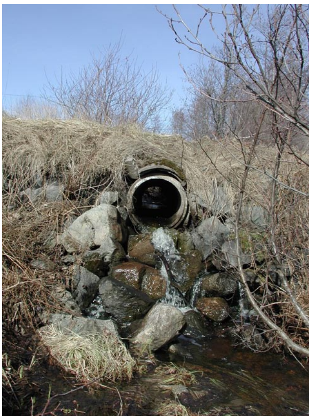
Bild 7: Punkt B22 i Bergshamraån. En trumma med stort fall som hindrar alla vandringsmöjligheter till sjön Skären.
