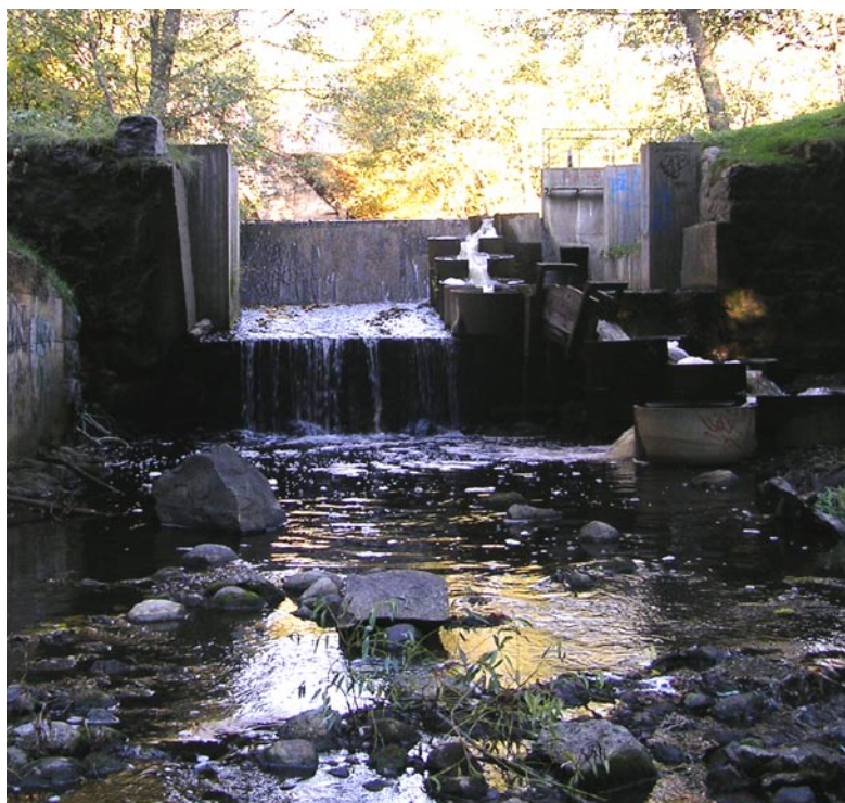
Bild 12: Punkt M5 i Moraån. Vid Järnadammen finns en fisktrappa anlagd.
