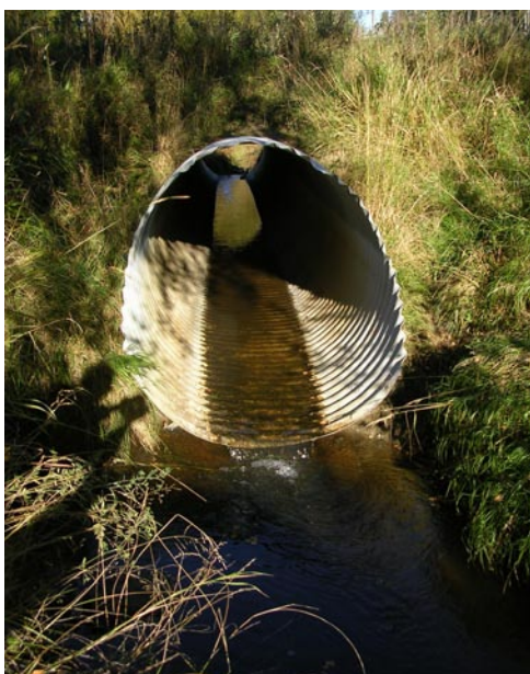
Bild 4. Exempel på en trumma (punkt 11 i Moraån) som utgör vandringshinder för såväl fisk som bottenfauna.
