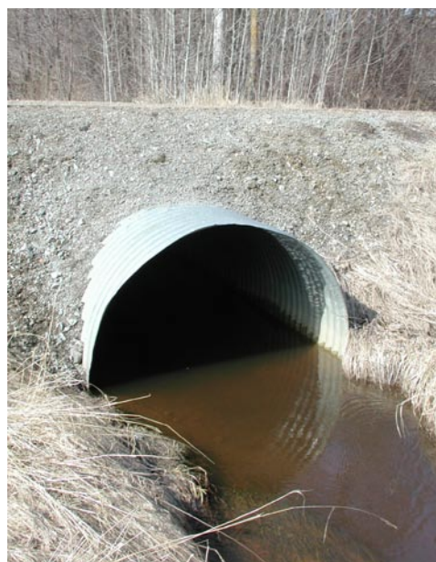
Bild 5. Exempel på en korrekt placerad trumma (punkt 10 i Husbyån) som inte förändrar vattendragets bredd och karaktär.
