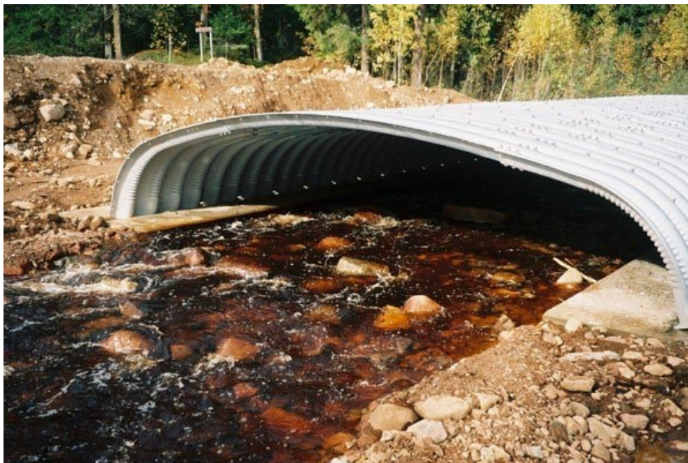
Bild 13 & 14. Bilderna är tagna vid ett biflöde till Unnån utanför Orsa i Dalarnas län. Vägverket har där åtgärdat ett antal felplacerade vägtrummor och ersatt dem med bl.a. halvtrummor. Ett mycket bra före/efter exempel på hur en lyckad fysisk åtgärd ska se ut! Foto: Ove Eriksson
