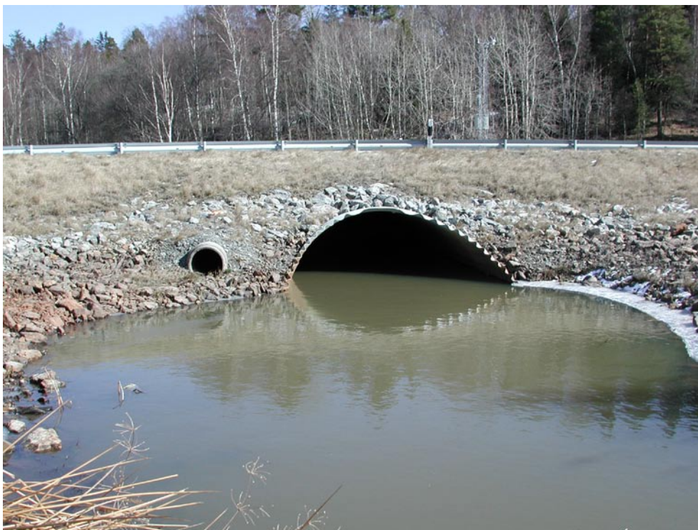
Bild 10. Punkt 9 i Kvarnbäcken under väg nr 73. Trumman bra placerad för den akvatiska faunan. Mindre däggdjur kan passera via den mindre trumman till vänster.
