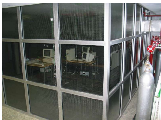
Foto. 2 Widok komory badawczej z przodu i z boku z widocznym kanałem
