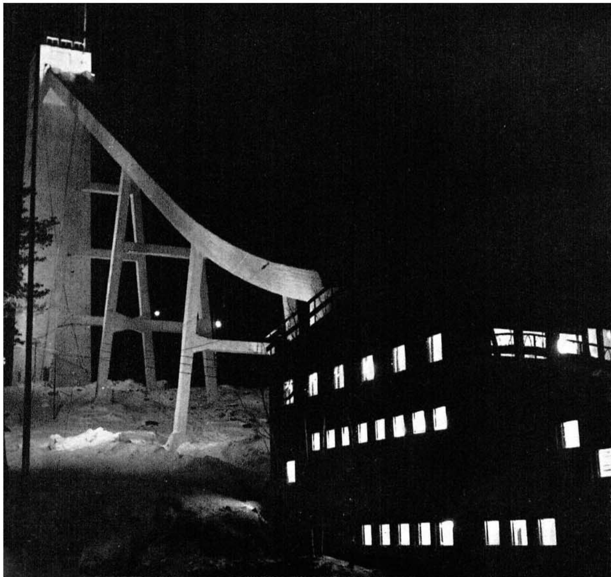
Øverst: Holmenkollbakkens fartstårn, hopp og tribunanlegg, fotografert umiddelbart før vinterlekene. De nederste tribuneradene i bakken er av betong, da vannet i tjernet (tappes ut om vinteren) står et stykke opp i overgangen om sommeren. I bakkant av tribunene ser man reportasjeboksene for presse og kringkasting (14 dobbelte på hver side). Midt på bildet (i overkant av tribunen) ser man Kongetribunen, vis å vis denne dommertårnet. Nederst: Hoppshuset fullt opplyst, og fartstårn og -til-løp flombelyst.
