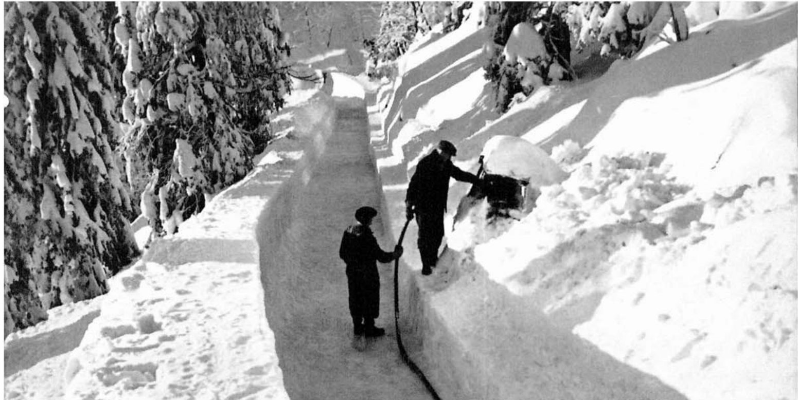
Bobsleighbanen for vinterlekene ble et helt nytt anlegg. Den ble lagt i Frogneråsen, ikke langt fra Holmenkollbakken. Temmelig omfattende grunnarbeider måtte til, men man fant det ikke hensiktsmessig å bygge opp eller støpe permanente doseringer. Selve isbanen ble derfor bygd opp på nytt både i 1951 og 1952, de to årene banen var i bruk. Kurvene ble bygd opp i snø og kjørebanelen planert. Deretter ble det hele oversprøytet med vann til en fast ismasse. Bildene: Øverst 1. kurve sett fra startstedet, i midten og nederst glimt fra prepareringsarbeidet.
