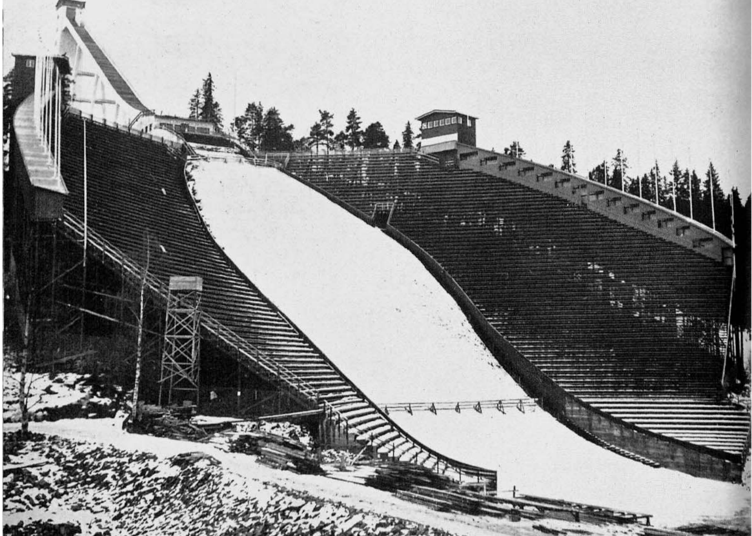
Øverst: Holmenkollbakkens fartstårn, hopp og tribunanlegg, fotografert umiddelbart før vinterlekene. De nederste tribuneradene i bakken er av betong, da vannet i tjernet (tappes ut om vinteren) står et stykke opp i overgangen om sommeren. I bakkant av tribunene ser man reportasjeboksene for presse og kringkasting (14 dobbelte på hver side). Midt på bildet (i overkant av tribunen) ser man Kongetribunen, vis å vis denne dommertårnet. Nederst: Hoppshuset fullt opplyst, og fartstårn og -til-løp flombelyst.
