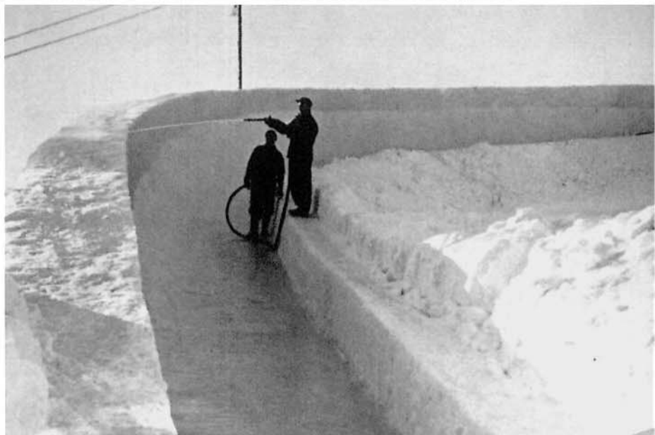
Bobsleighbanen for vinterlekene ble et helt nytt anlegg. Den ble lagt i Frogneråsen, ikke langt fra Holmenkollbakken. Temmelig omfattende grunnarbeider måtte til, men man fant det ikke hensiktsmessig å bygge opp eller støpe permanente doseringer. Selve isbanen ble derfor bygd opp på nytt både i 1951 og 1952, de to årene banen var i bruk. Kurvene ble bygd opp i snø og kjørebanelen planert. Deretter ble det hele oversprøytet med vann til en fast ismasse. Bildene: Øverst 1. kurve sett fra startstedet, i midten og nederst glimt fra prepareringsarbeidet.
